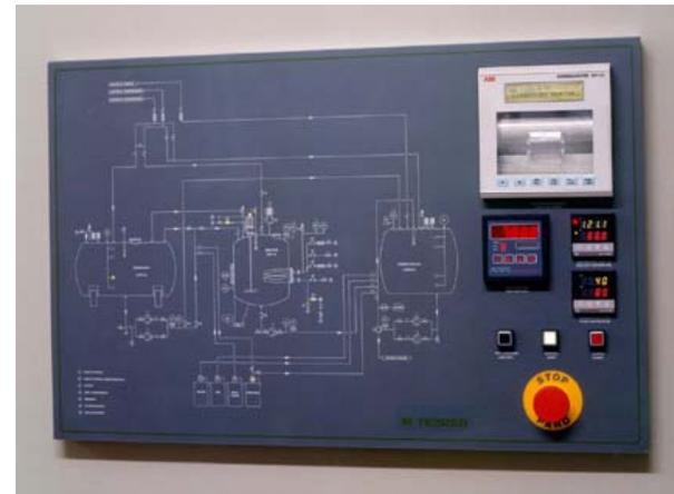
**Reservorio / Reactor:** 3.000 Lts, Presión Atm, temperatura ambiente, inox. Para esterilización química dotado de loop recirculación. Red independiente.
